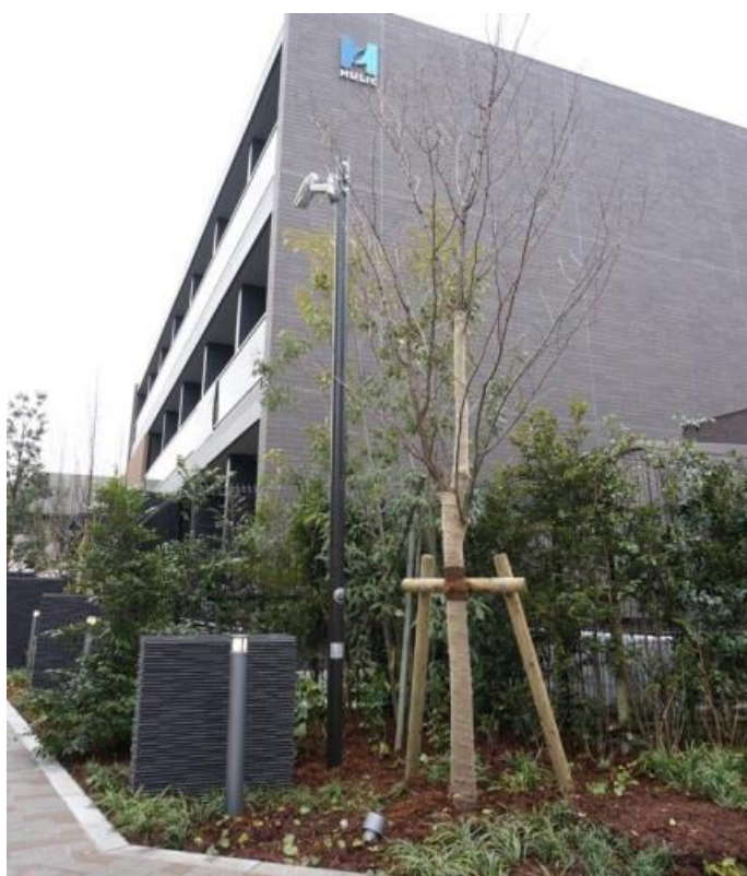
図. 竣工直前の外構（2014年撮影）
