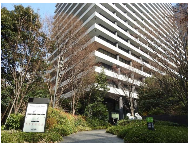
エントランス付近
