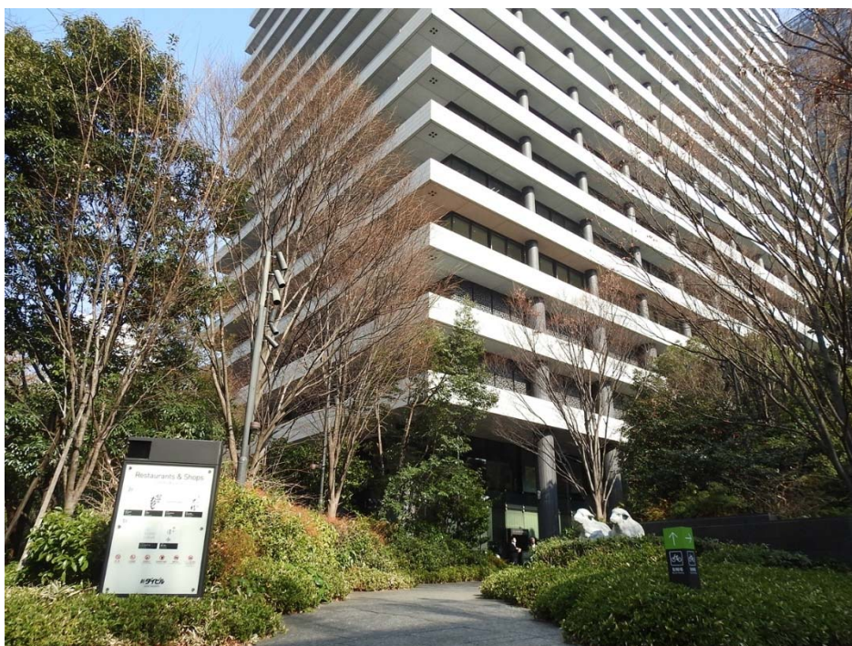
図. エントランス付近
