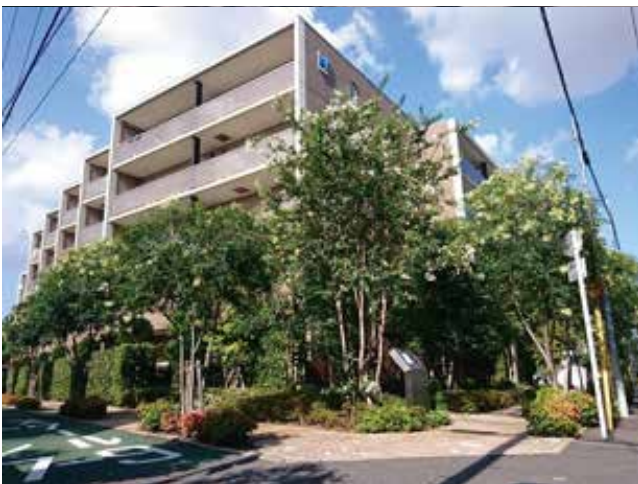
ヒューリックコート雪が谷の外観
