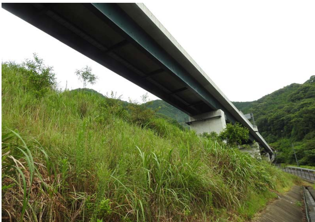
図. 地域性苗木が植栽された区画
